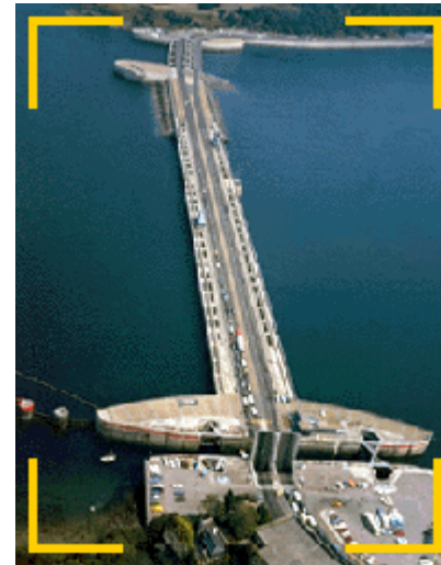
La Rance – Tidal Barrage
